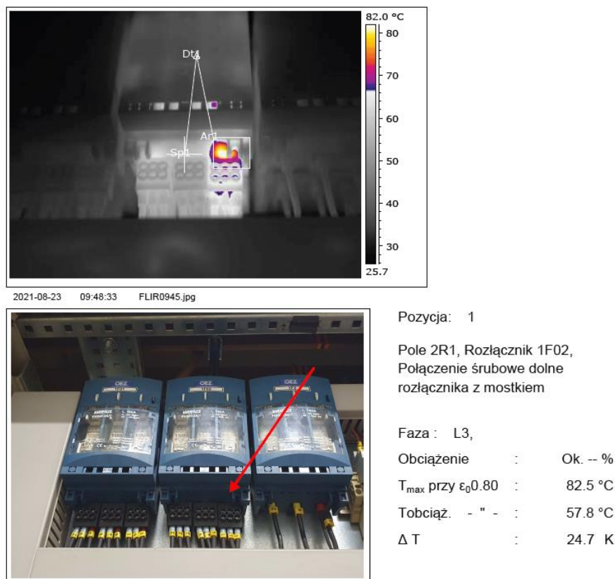
Zdjęcie 2. Przykład pomiaru termografii – wykonane przez podmiot zewnętrzny (certyfikowany) Źródło: Opracowanie własne: na podstawie protokołu z badań specjalistycznej firmy zewnętrznej.
