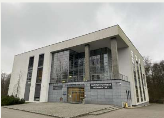
Institut für Mechanische Ingenieurwissenschaften
